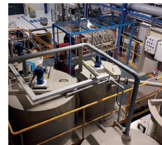
Station physico-chimique, évaporateur et cuve de stockage d'eau recyclée en industrie du traitement de surface
